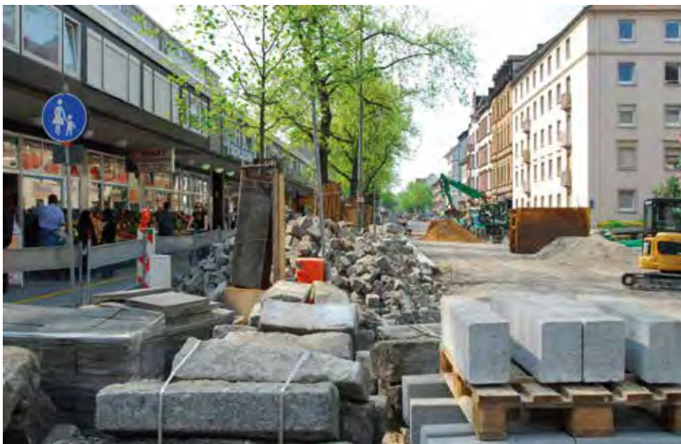
Bauarbeiten bei der Ladenzeile Sophienstraße
